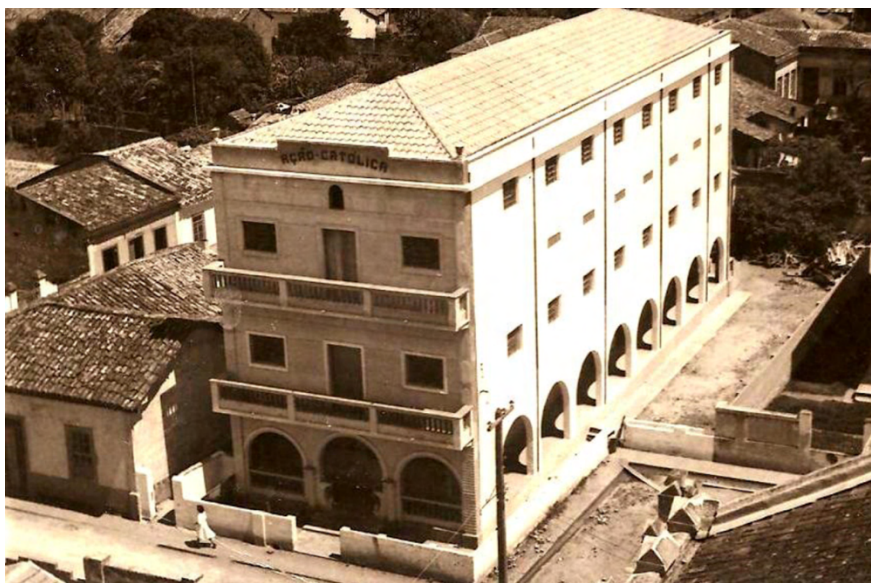
Prédio com versão original, telhado em 4 águas. Pináculo lateral com 8 arcos plenos. Possivelmente 1958.
