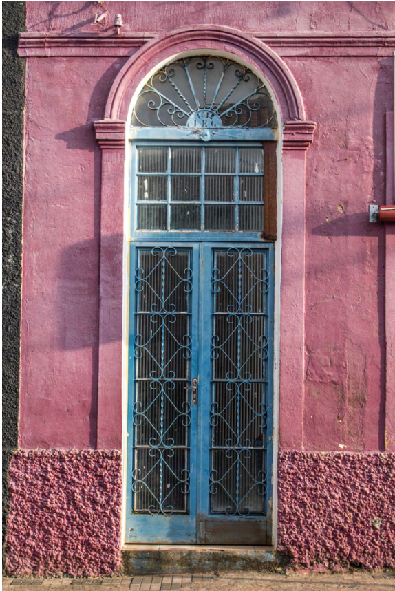
Porta de acesso pela rua Silva Jardim, com as duas bandeiras, sendo a mais alta em arco pleno. Foto: Verônica Volpato, 2023.
