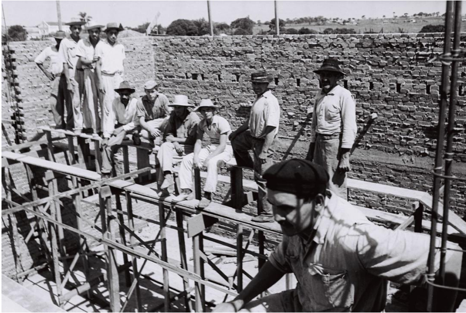
Trabalhadores na construção, década de 1950. Autor desconhecido. Acervo Assis.
