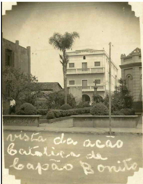
“Vista da Ação Católica de Capão Bonito”. Final da década de 1950.
