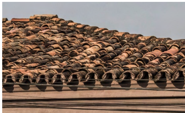
Telhas originais do tipo calha e canal. Foto: Verônica Volpato: 2022
