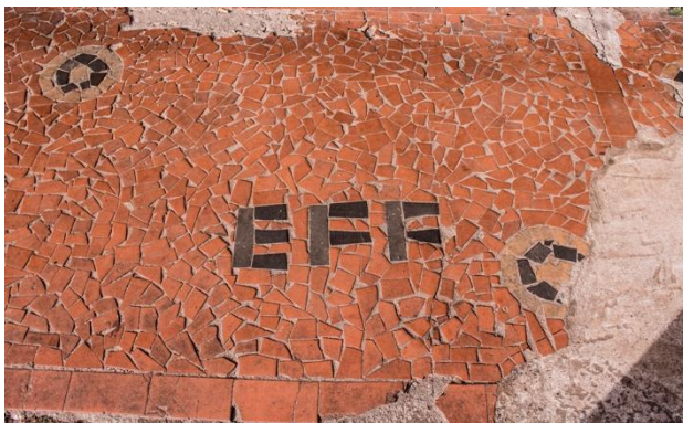
Detalhe da calçada com cacos de lajota paulistana. Provavelmente as letras significam "Empresa Franco e Franco", primeira denominação oficial da fábrica, 2023
