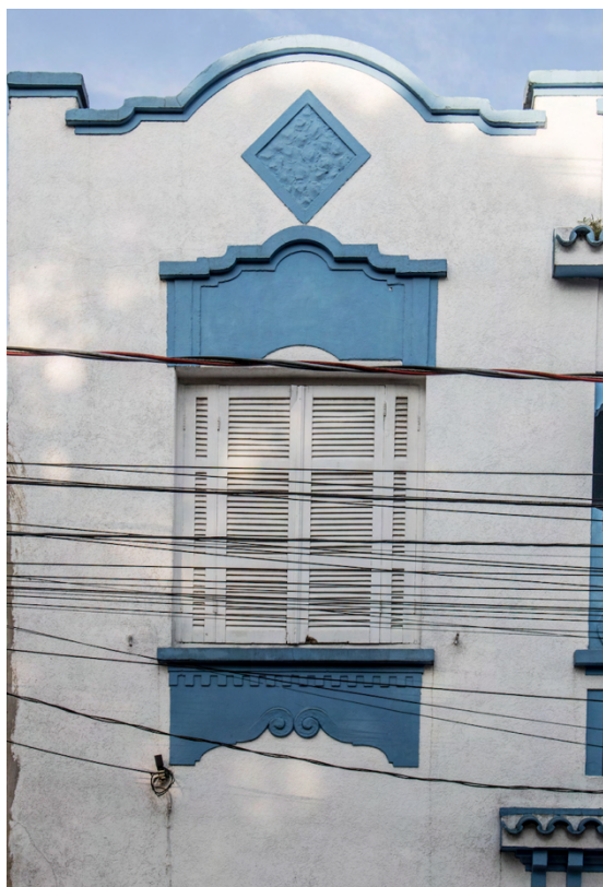
Detalhe do ornamento em estilo art déco abaixo do parapeito da janela, ornamento em medalhão entre a esquadria e a platibanda. Foto: Verônica Volpato: 2022
