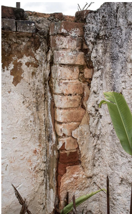
Registro do formato original do muro entorno do cemitério com tijolos simples. Fotografia: Verônica Volpato, 2022.
