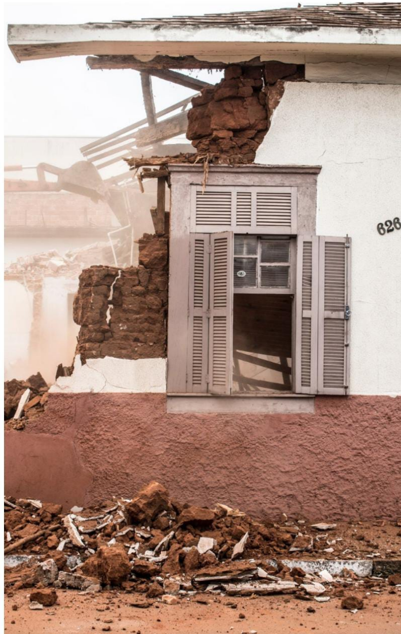
Demolição de casarão centenário na Rua Geral Carneiro – Foto: Veronica Volpato. Capão Bonito, 2023
