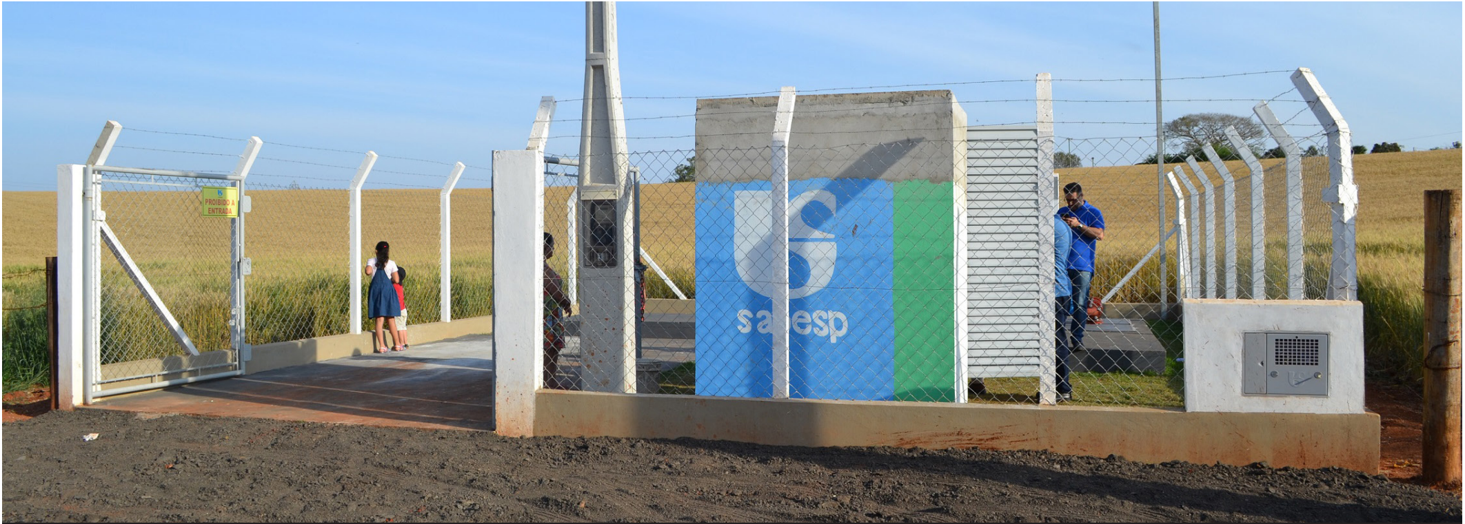
Obras de construção de redes coletoras de esgoto ajudam a diminuir déficit de saneamento básico
